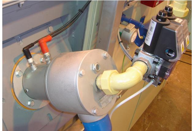
Note – le bouchon d'ionisation aura une haute tension une fois déconnecté. Par conséquent, il ne faut pas le changer sans couper le courant.
