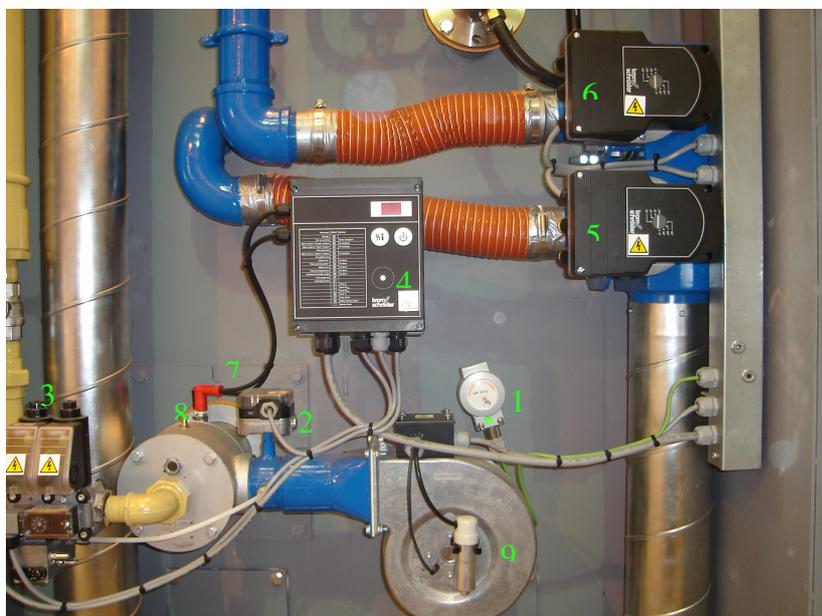
1. Thermocouple chambre post combustion
