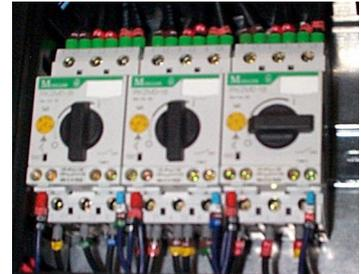
Si le disjoncteur principal a disjoncté, l'actuateur est tourné à gauche (sur la figure, exemple de pulvérisateur qui a disjoncté).
