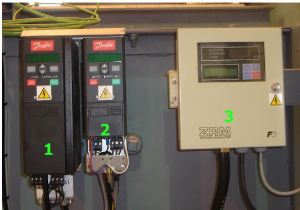
1. Module de commande du ventilateur d'éjection
